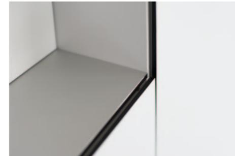
1 Eloxiertes Aluminium (Alucobond) mit einem Profil von 6 Millimetern.
